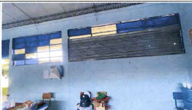
Foto7: Ventanales en aulas
