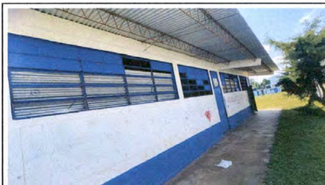
Foto 4: Fachada frontal modula de aulas
