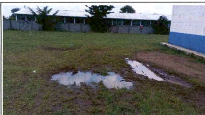
Foto 3: Area de gramilla dañado
