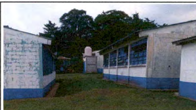
Foto 12: Modulos de aulas
