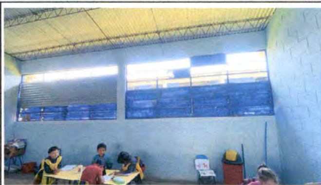
Foto 8: Ventanales en aulas
