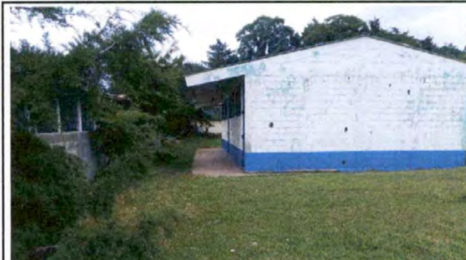
Foto 2: Fachada lateral modulo de aulas
