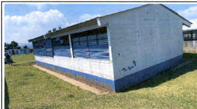
Foto 6: Fachada posterior modulo de aulas
